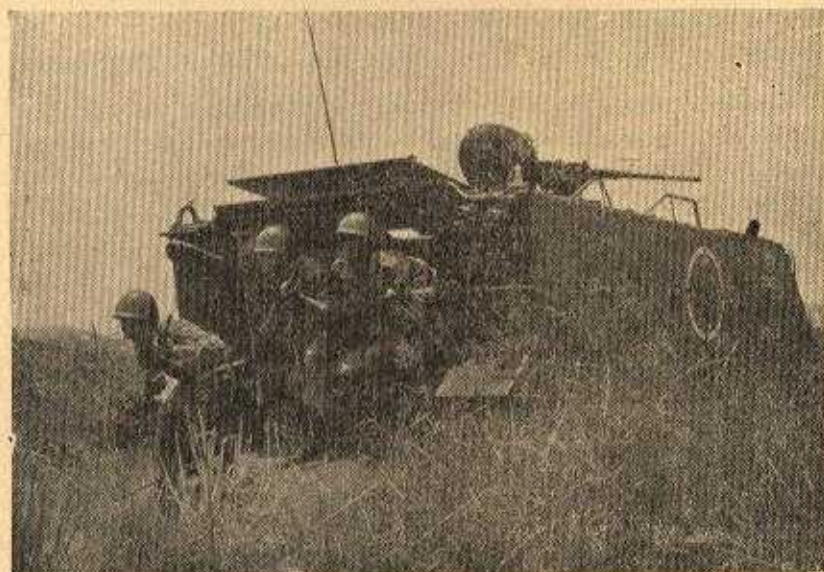
Viatura Blindada Transporte Pessoal — M 113 Capacidade de transporte: 13 homens Armamento: Mtr .50 — Peso: 10 ton. Velocidade: 65 km/h.
