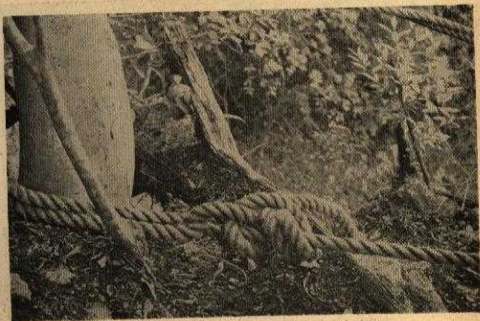
Foto 6 — Laçada da extremidade de saída do cabo aéreo
