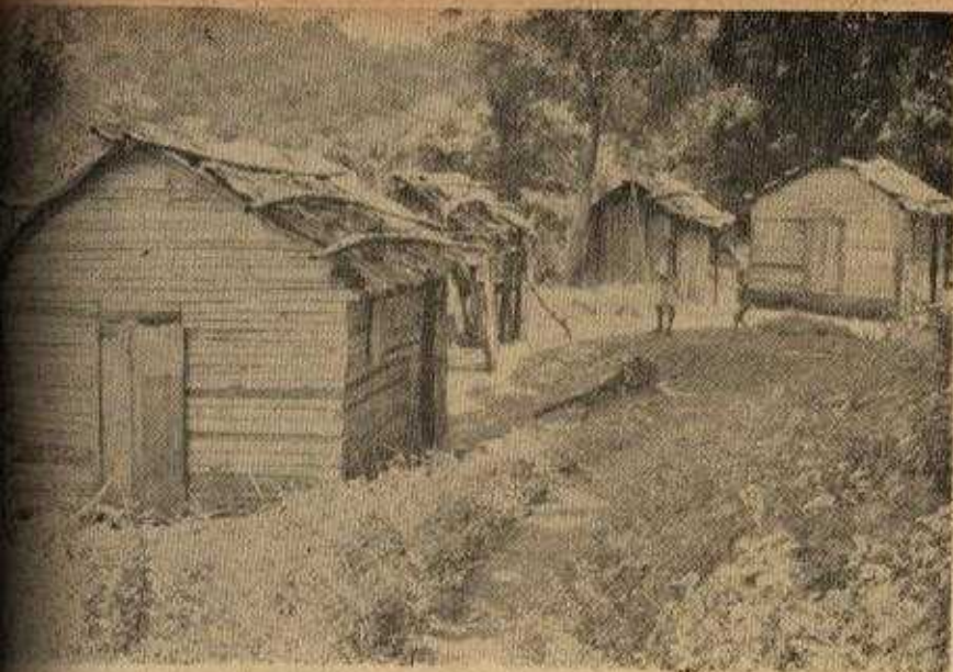
Casobres existentes na área de instrução
