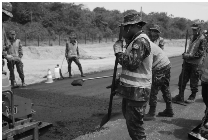
Figura 1 – Pavimentação asfáltica da BR-432/RR Fonte: 6º BEC (2019)
