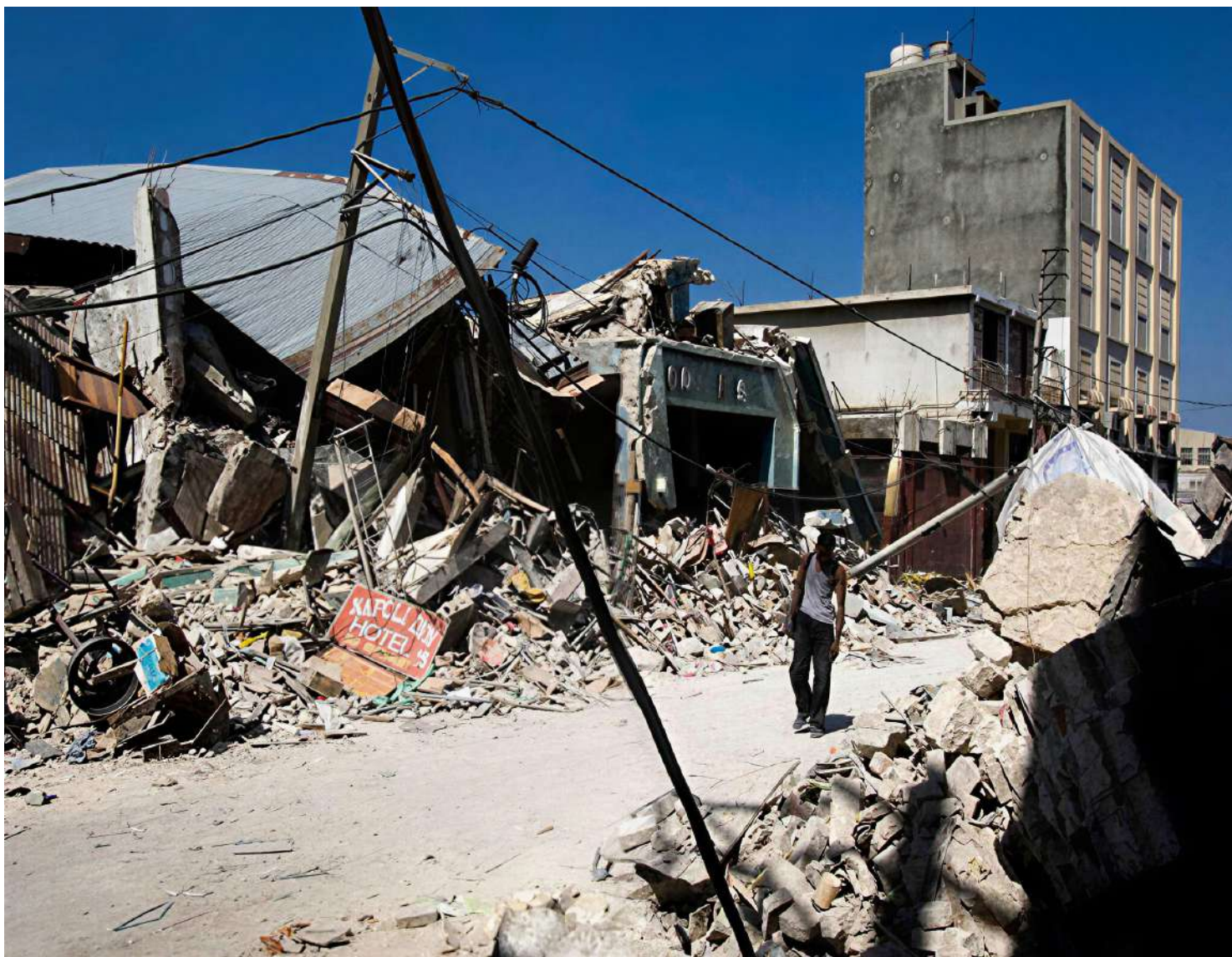
Fig. 2 – Cidadão haitiano caminha no meio de edifícios que sucumbiram ao terremoto de 12 de janeiro de 2010, no centro de Porto Príncipe.
