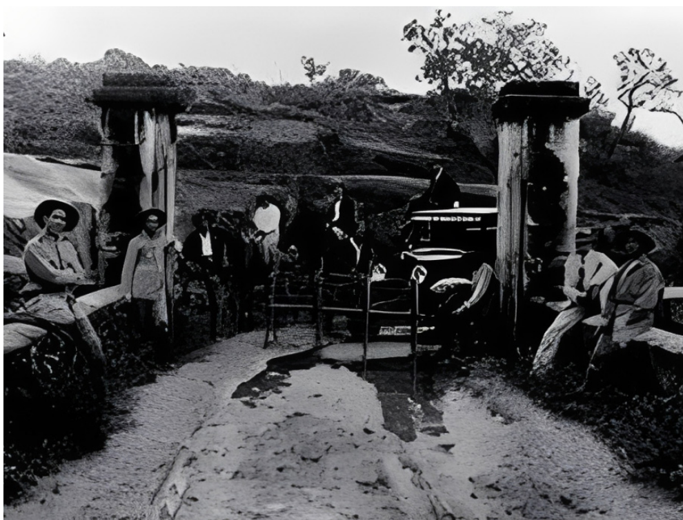
Fig. 4 - Tomada de ponte em Itararé. É possível que o 13º BC tenha auxiliado na ação
