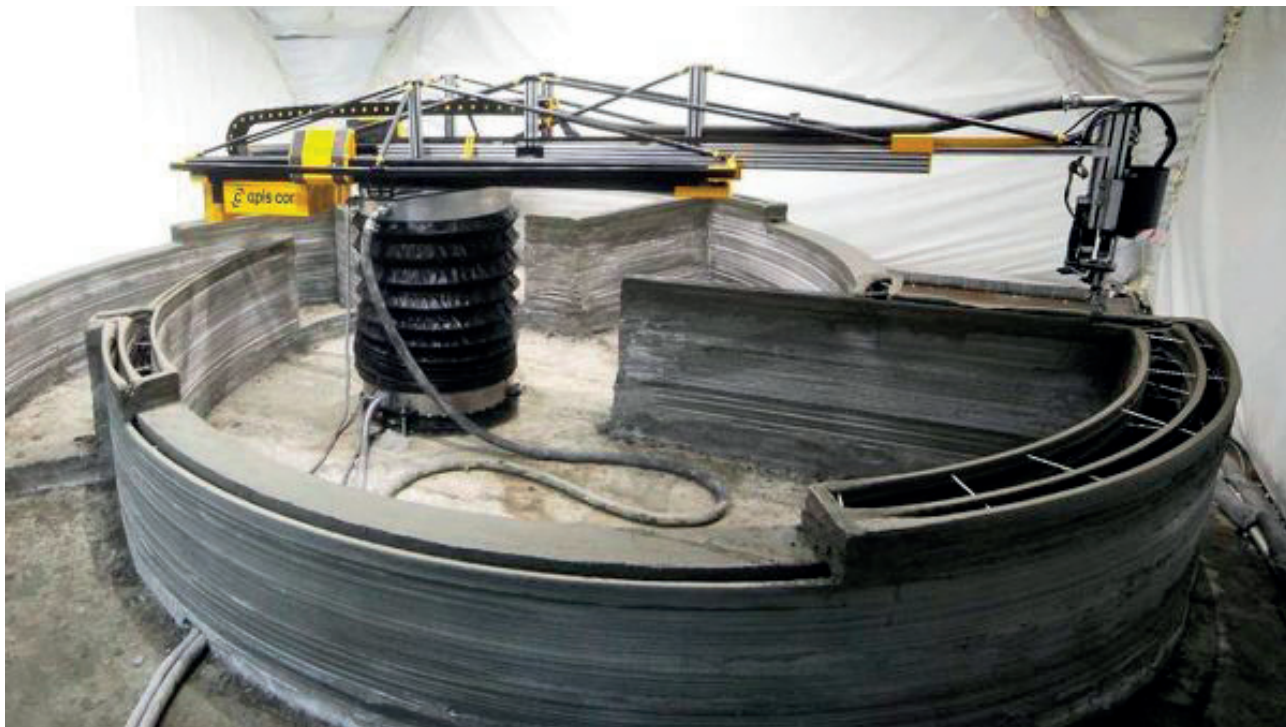
Fig 10 - Impressora 3D tendo concreto como matéria prima
