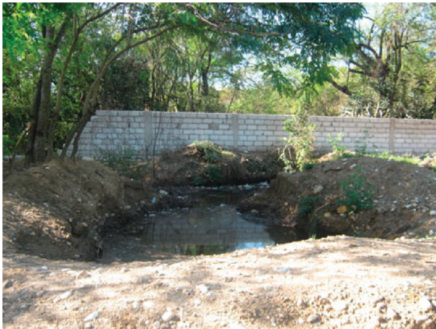
Figura 3. Fossa destinada aos rejeitos do acampamento de Mirebalais (LANTAGNE et al, 2013).
