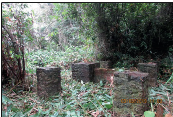
Figura 13 – Colunas de pedra que suportavam a caixa d'água que supria os paióis
