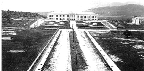
Figura 2 – Instalações definitivas da EsAO: pavilhão principal, concluído em 1924
