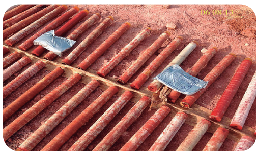
Figura 5 – Disposição dos propelentes sobre o papel parafinado Fonte: 12ª Cia E Cmb L (2013)
