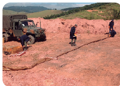
Figura 4 – Colocação do papel parafinado Fonte: 12ª Cia E Cmb L (2013)
