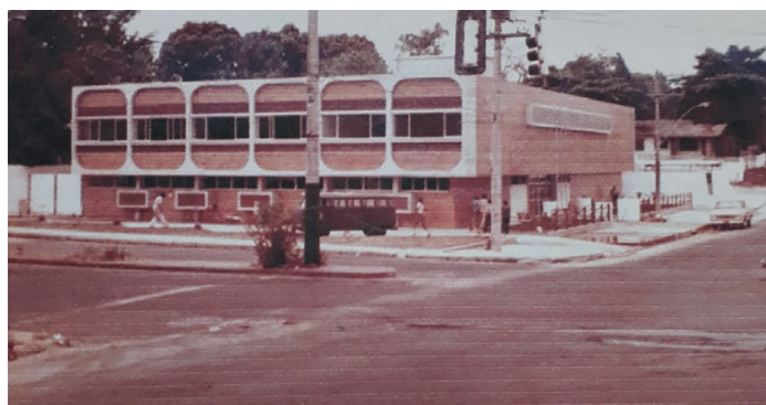
Construção da 2ª ISFEx, em Manaus, concluída em 1979. Fonte: 3º CGCFEx
