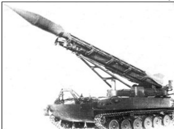
Figura 2 – Unidade de Lançamento do Sistema Luna 3R10 com Ogiva Nuclear Tática
