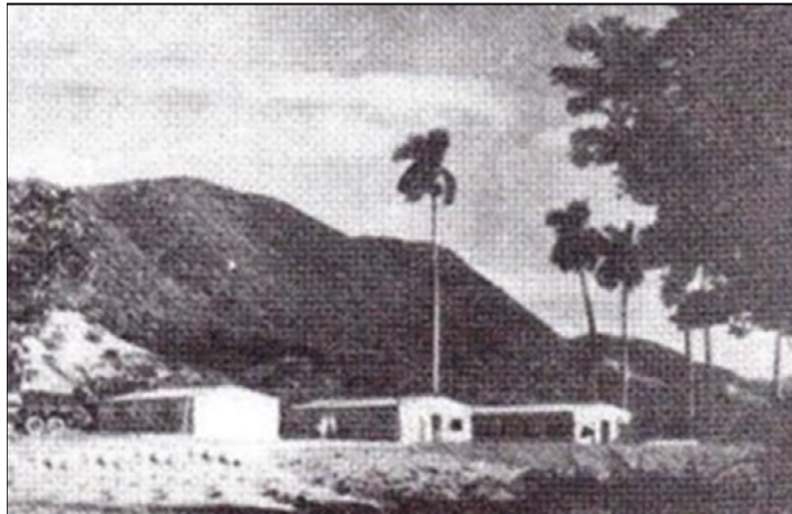
Figura 6 – Alojamento para oficiais em estruturas modulares
