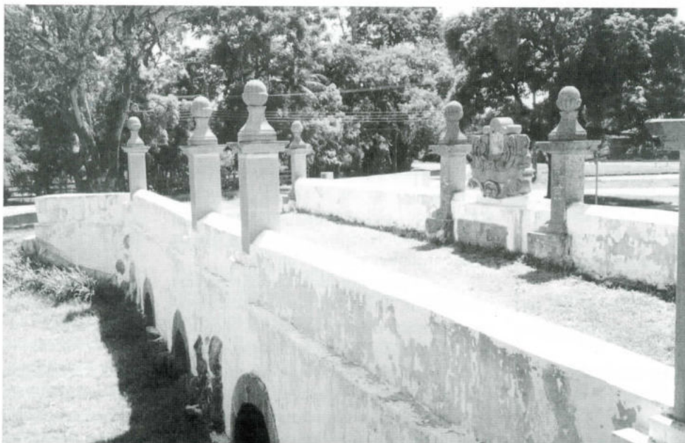
Foto: Ponte dos Jesuítas
