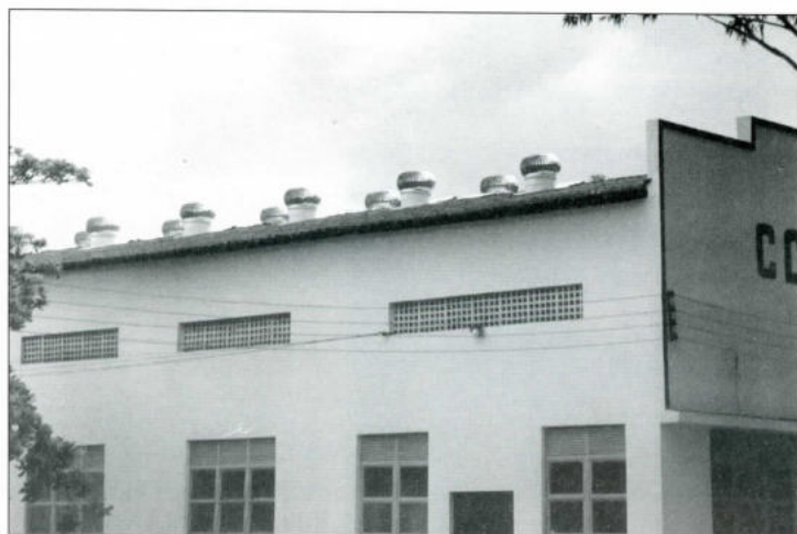
Instalação de exaustores eólicos nos alojamentos dos alunos do Curso de Formação de Sargentos (CFS).
