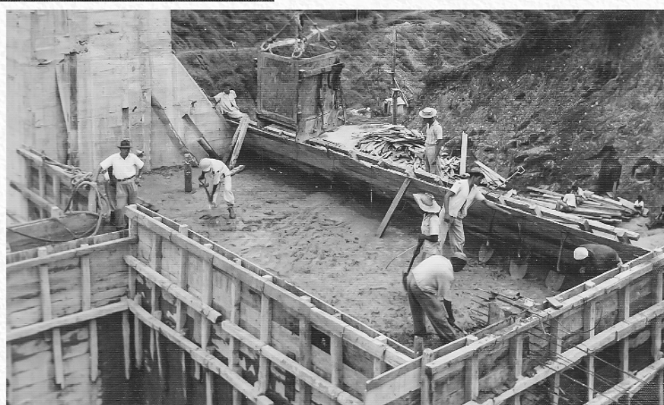
Fase de construção da usina
