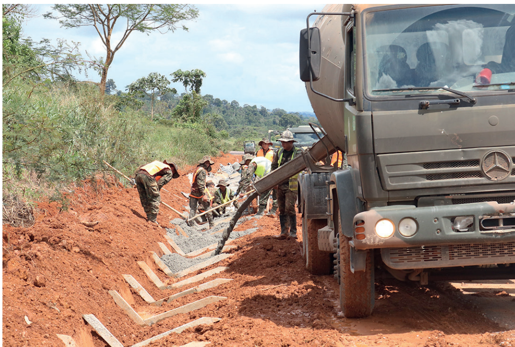
Figura 3 - Processo de drenagem da BR-163
