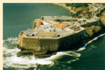
Recuperação da Fortaleza de Santa Cruz, RJ
