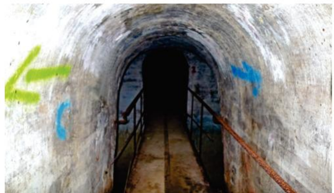
Passarela de acesso às cisternas [@Valdenebro]
