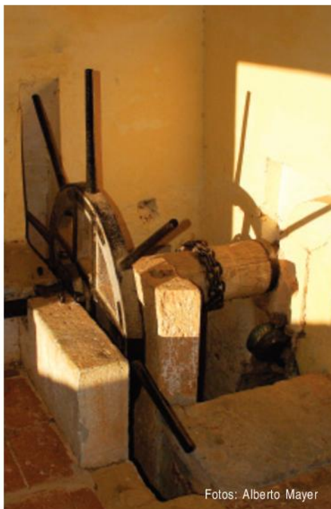
Mecanismo da ponte levadiça que permite a passagem ao reduto central
