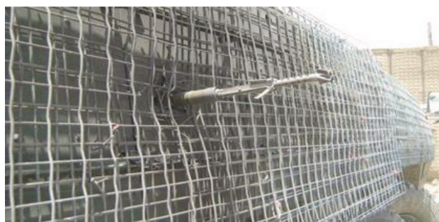
Figura 8: Blindagem do tipo gaiola impedindo a detonação de RPG.
