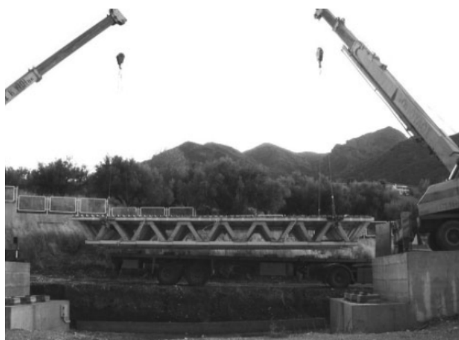
Fig. 14 – Instalação da ponte sobre o vão com o auxílio de guindastes. Fonte: [9].
