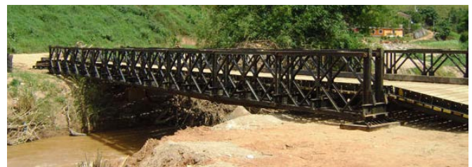
Fig. 2 – Ponte Bailey dupla-simples. Fonte: [4].
