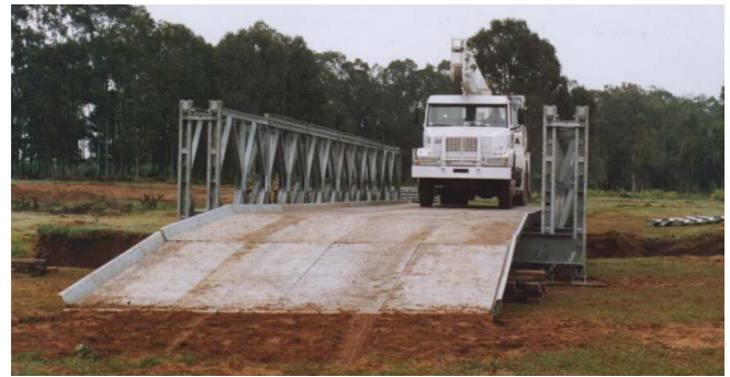
Fig. 8 – Ponte Compact 200 dupla simples. Fonte: [6].
