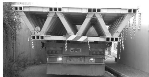
Fig. 13 – Transporte da estrutura sobre caminhão. Fonte: [9].
