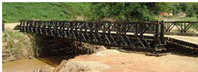
Fig. 2 – Ponte Bailey dupla-simples. Fonte: [4].
