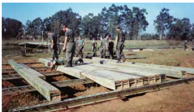
Fig. 6 – Ponte M4T6 durante a montagem. Fonte: Acervo dos autores.
