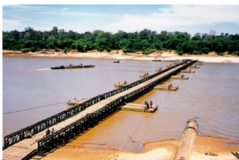
Fig. 4 – Ponte Bailey (apoiada em uníflotes). Fonte: [23].
