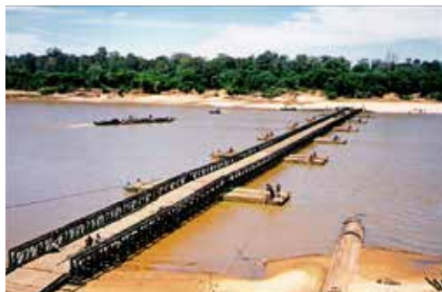
Fig. 4 – Ponte Bailey (apoiada em uniflotes). Fonte: [23].
