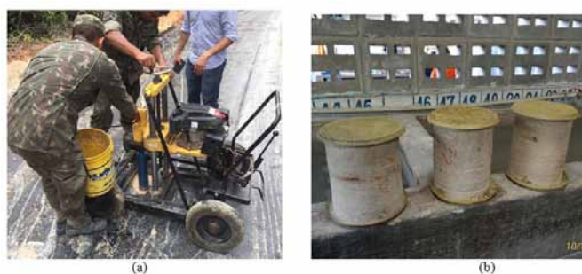
Fig. 6 – Extração de CPs da pista (a) e aspecto final (b).
