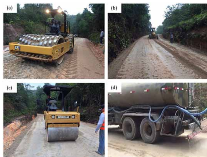
Fig. 3 – Etapas de (a) compactação, (b) abaulamento, (c) acabamento final e (d) cura do solo.
