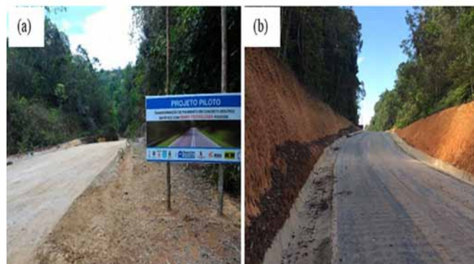
Fig. 5 - Aspecto final da seção teste com 1 dia de conclusão em 10/16 (a) e após 490 dias em 02/18 (b).
