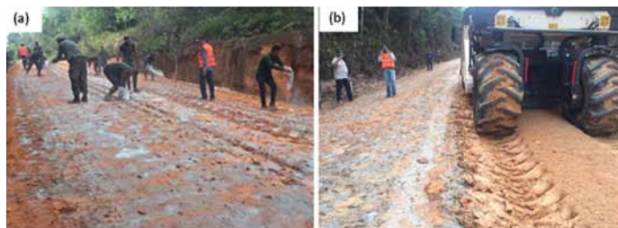
Fig. 2 – Distribuição do ZS por (a) espalhamento manual do e (b) homogeneização com solo in situ através da recicladora.
