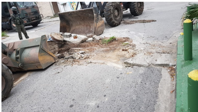
Figura 7 – Engenharia liberando acesso no Jardim Catarina, São Gonçalo, RJ.
