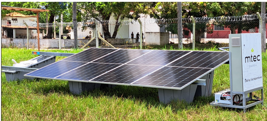
Figura 6 – Módulo 2: Módulo de Energia de Campanha sobre lastro solar (exemplo com quatro módulos)
