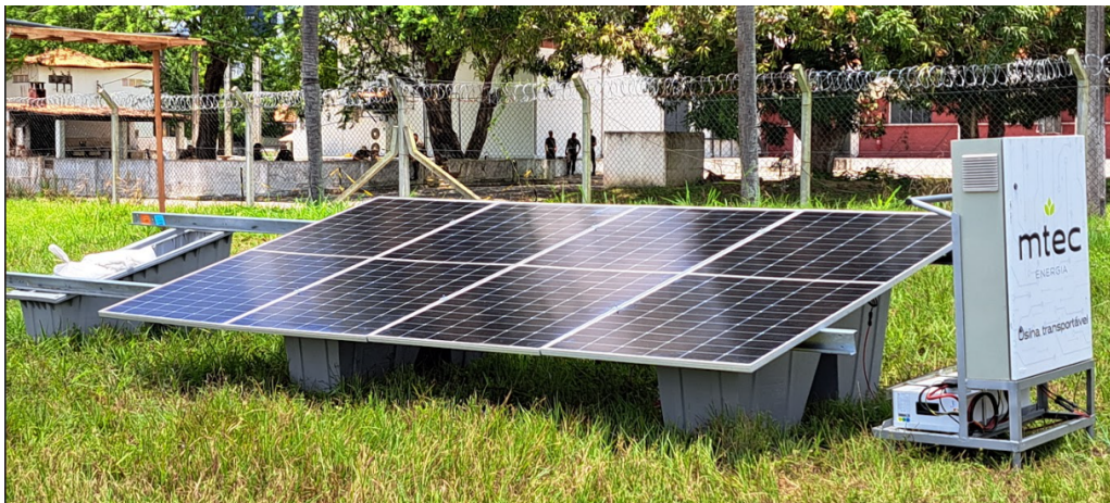
Figura 6 – Módulo 2: Módulo de Energía de Campaña sobre lastre solar (ejemplo con cuatro módulos)
